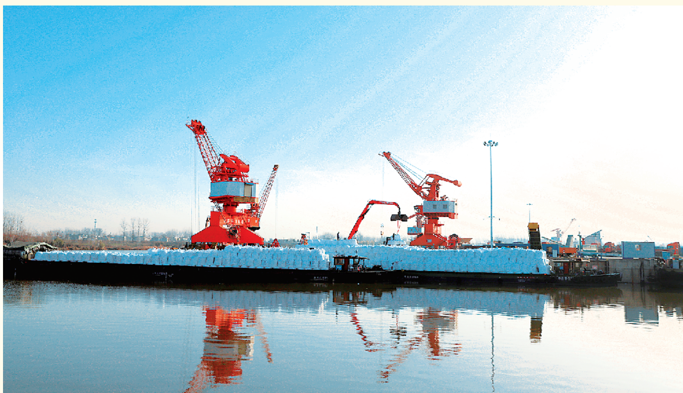
今年以来,周口临港开发区加快推进码头基础设施建设,大力发展临港贸易,不断畅通国内、国际集装箱航线,货物吞吐量持续攀升。图为12月23日清晨,周口中心港码头作业现场。 记者 宋风 摄
